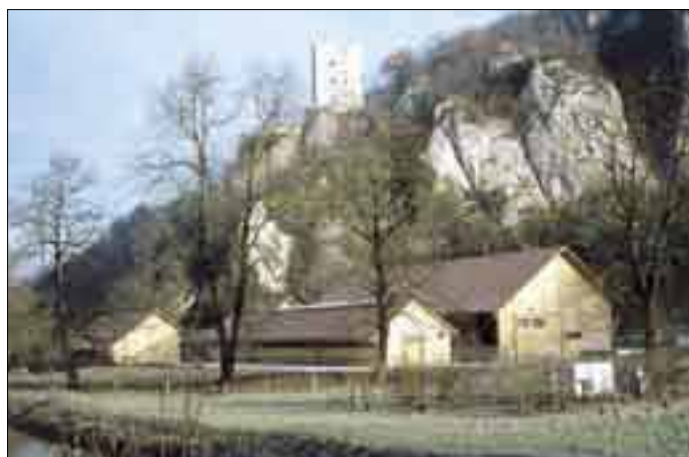
Stallneubau Schlosshof in Büsserach BL. Ausgeführt wurde ein Stall- und Scheunenneubau mit Remise. Es handelt sich um einen Zweiraum-Laufstall mit Laufhof. Die ganze Anlage befindet sich in der Landwirtschaftszone (Juraschutzzone), in unmittelbarer Nähe zur Schlossruine Büsserach. Die Planung erfolgte durch das LBA Brugg.
