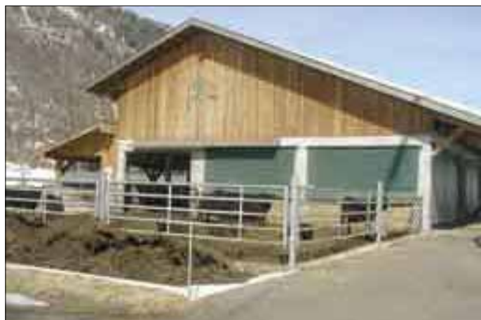
Neubau Ökonomiegebäude für eine Mutterkuhherde der Rasse Galaway in Obergesteln VS. Baujahr: 1997, Planung: LBA Visp
