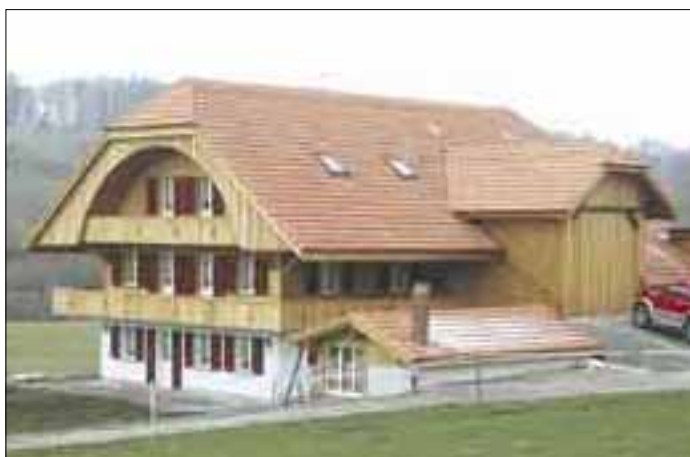
Bauernhaus in Uetendorf BE. Der Wohnteil des Bauernhauses befand sich in einem sehr schlechten Zustand. Deshalb wurde er bis auf den Dachstuhl, der erhalten blieb, abgebrochen und im Originalzustand wieder aufgebaut. Die Planung erfolgte durch das LBA Heiligenschwendi in enger Zusammenarbeit mit der Denkmalpflege des Kantons Bern.
