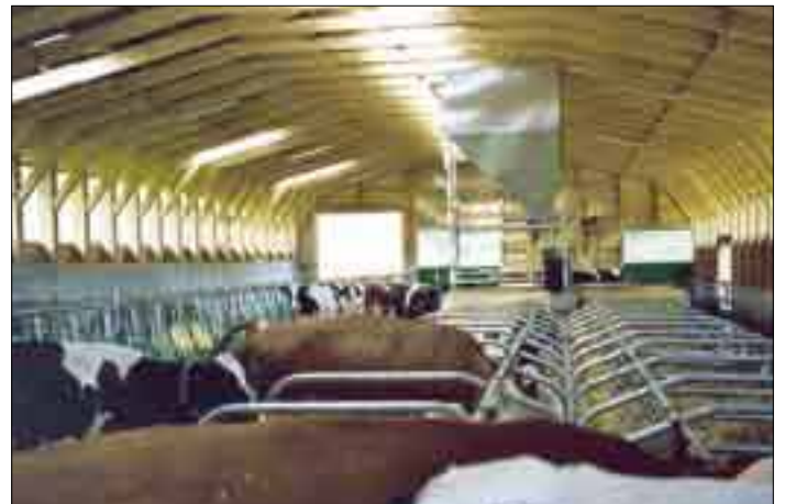
Stallneubau in Zunzgen BL. Es handelt sich um einen Starrrahmen-Milchviehstall, der mit viel Eigenleistung erstellt wurde. Der neue Melkstand befindet sich im alten Stall und ist ein 2x3-Fischgrätenmelkstand. Der Stall wird entmistet durch eine Klappschieberentmistung. Die Planung erfolgte durch das LBA Brugg.
